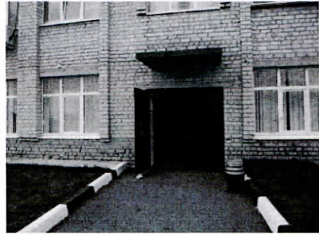
Фото №2 – Вход в здание
